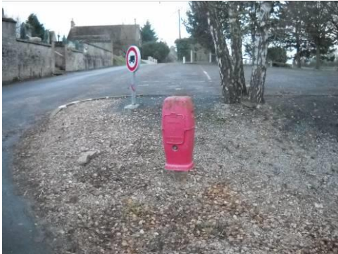
Poteau incendie situé dans le bourg
