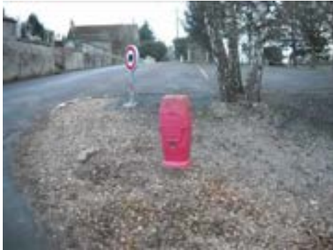
Poteau incendie situé dans le bourg
